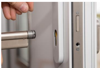
Schritt 1: Zylinder durch die Tür schieben
