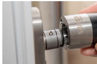
Schritt 3: Knauf aufsetzen
