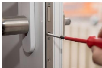
Schritt 2: Zylinder fixieren
